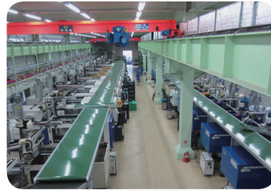
중앙 콘베이어 시스템 Centralized Conveyor System
